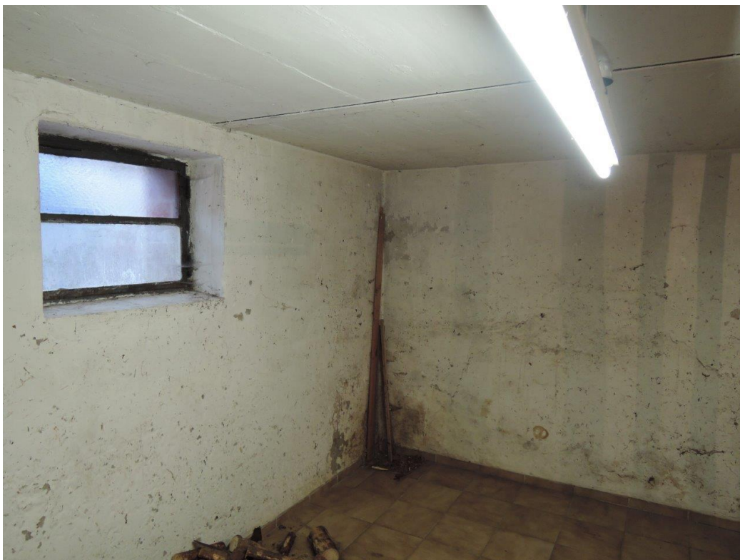
Foto č. 12 – Sklep – vlhké stěny s plísní na povrchu
