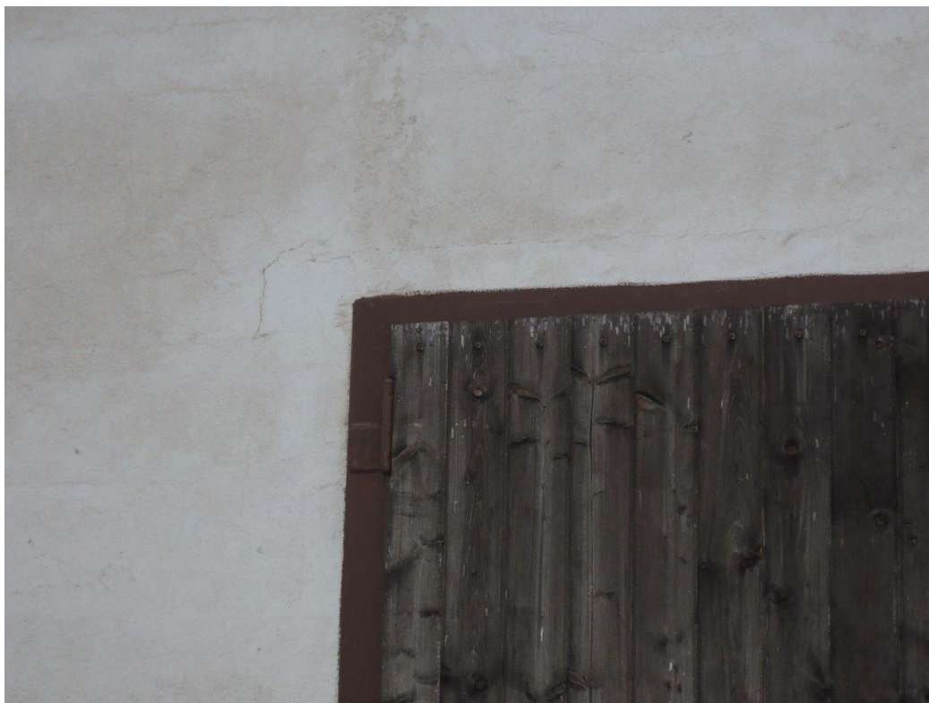
Foto č. 1 - Garáž – trhlina 2,0 mm
