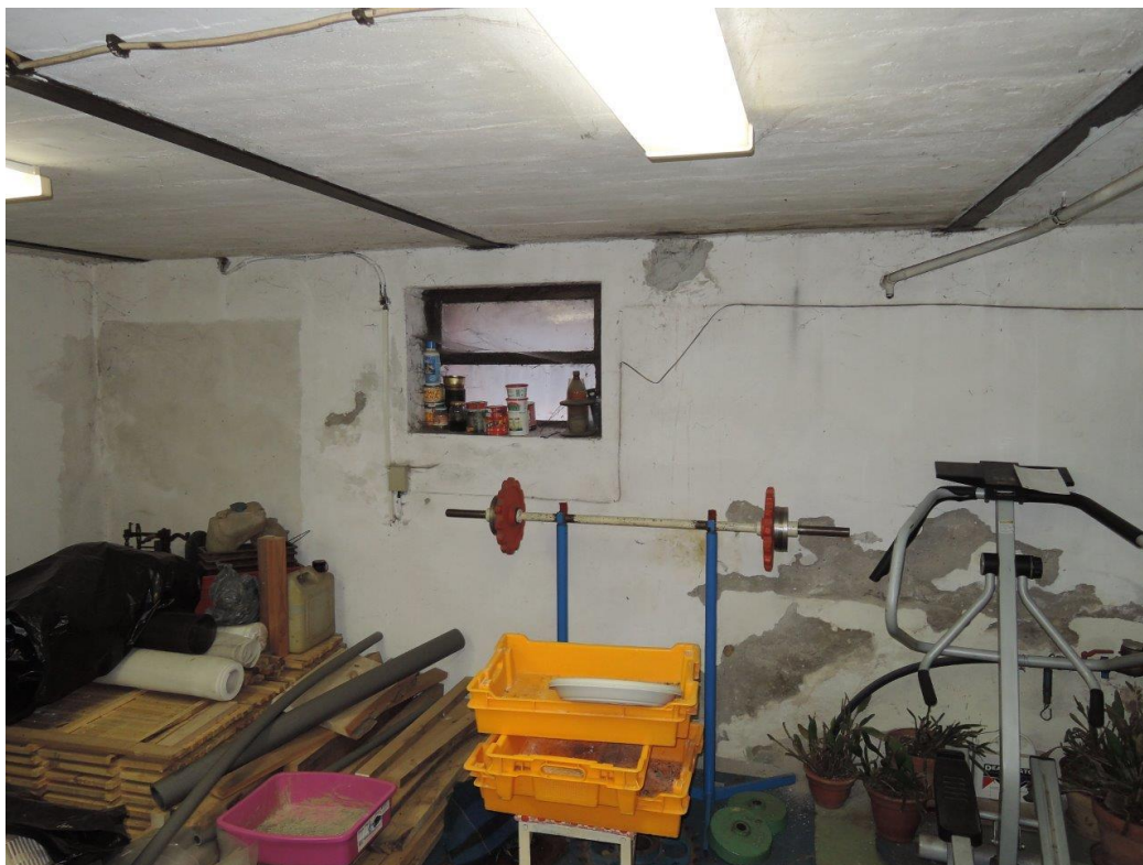
Foto č. 11 – Sklep – plíseň, opadaná omítka
