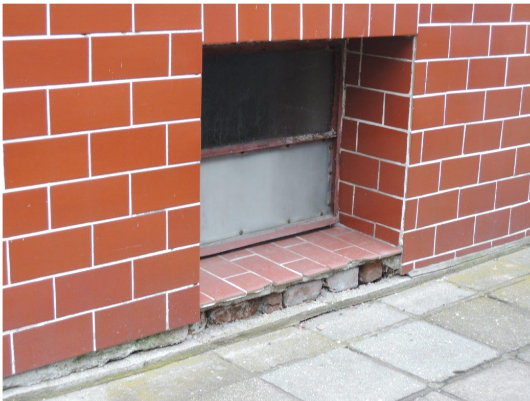
Foto č. 2 – Pohled na západní část fasády – opadaný obklad
