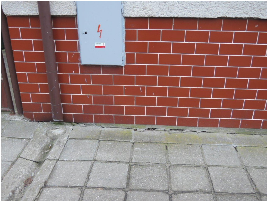
Foto č. 1 – Pohled na západní část fasády – uvolněná podezdívka
