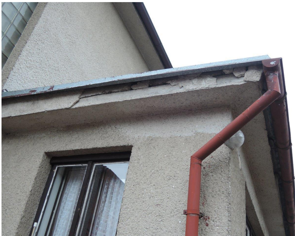
Foto č. 5 – Pohled na západní část fasády – opadaná omítka
