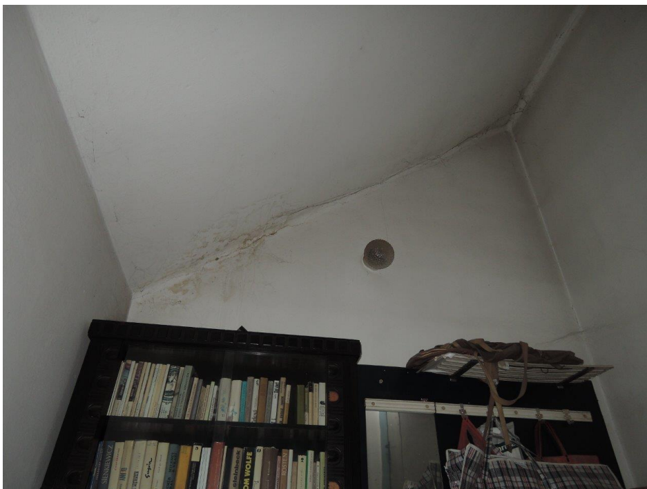
Foto č. 16 - Schodiště - popraskaný podhled
