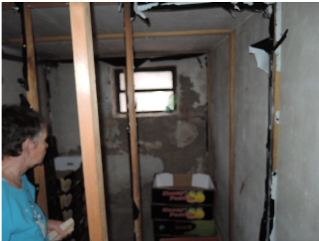
Foto č. 10 – Sklep – plíseň na zdivu
